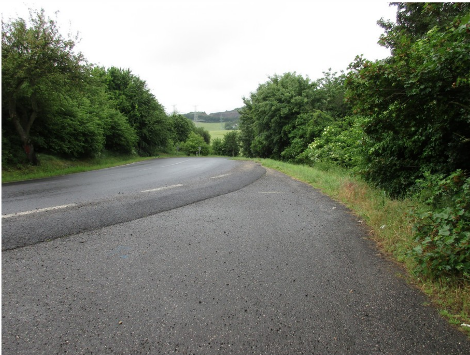
3. pohled ze silnice bez označení na silnici č. 224 směr Kadaň
