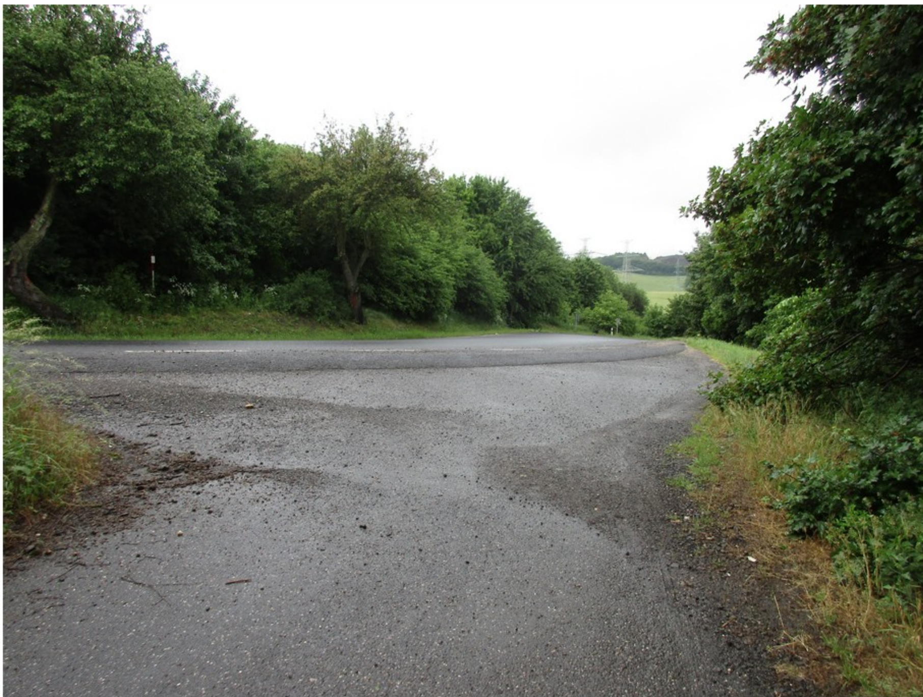
1. pohled ze silnice bez označení na silnici č. 224
