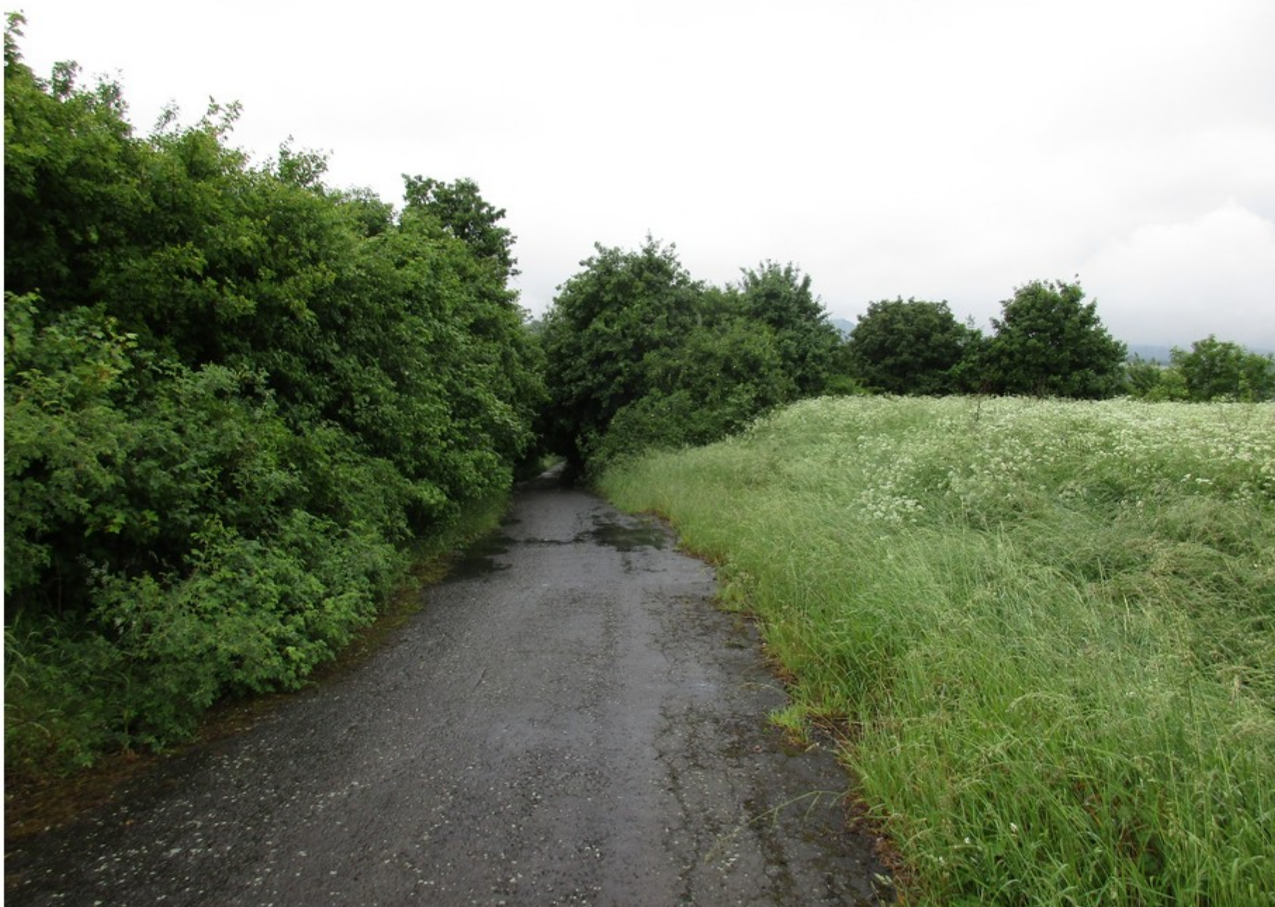
46. pohled na silnici od obce Hradec směr Kadaň
