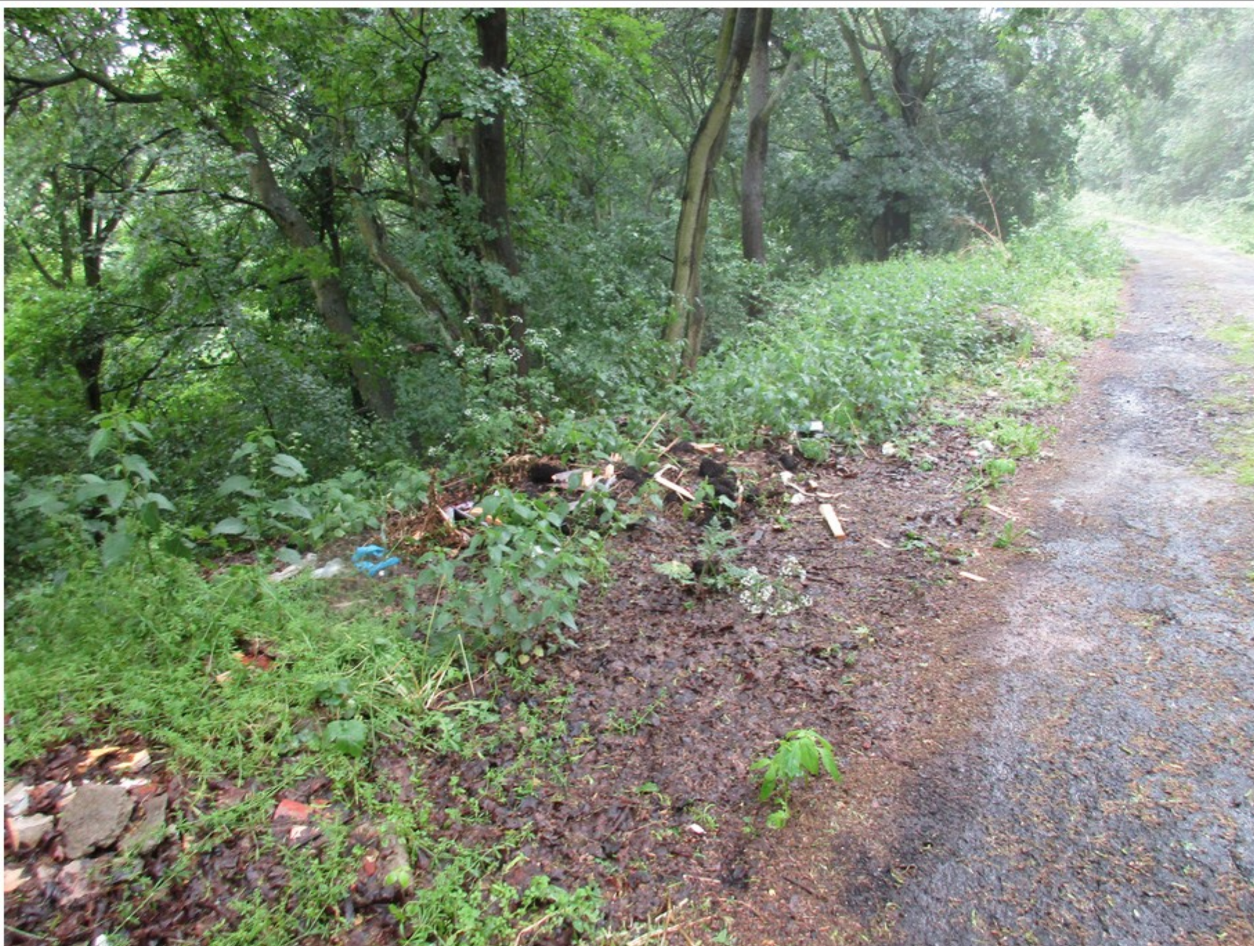
14 pohled na silnici a skládku
